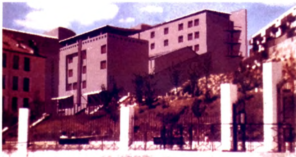
Le quartier de Belleville, "reconstruit" autour du projet.
